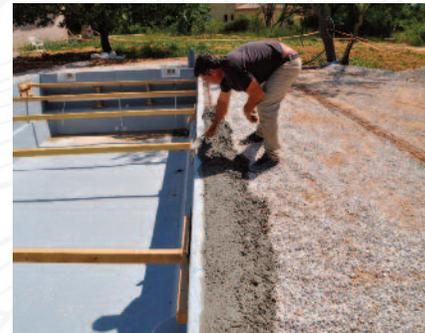
8 Etayage et ceinture béton armé
